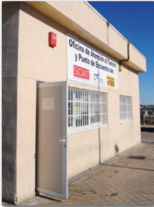
Esta oficina se encuentra a la entrada de la bolsa de la T4.
