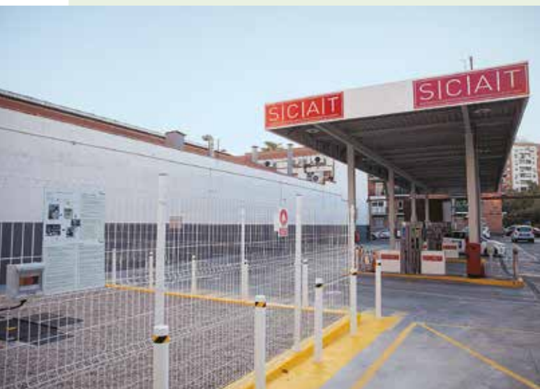
Nuevo tanque de AutoGas en Cooperativa
